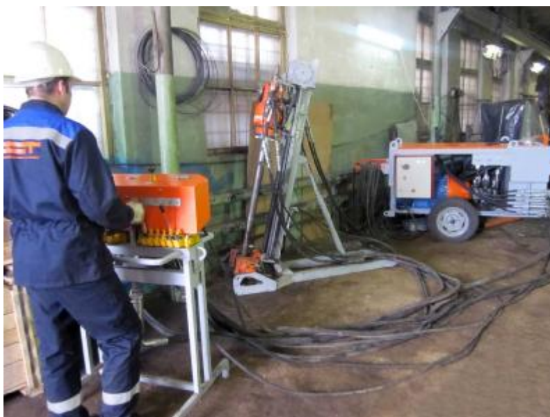
Рис.3. Производство работ в действующем цехе с электрической маслостанцией
