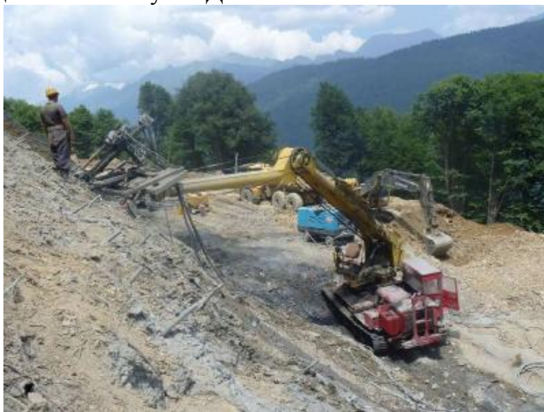
Рис.4. Установка нагелей Figaro Maschine
