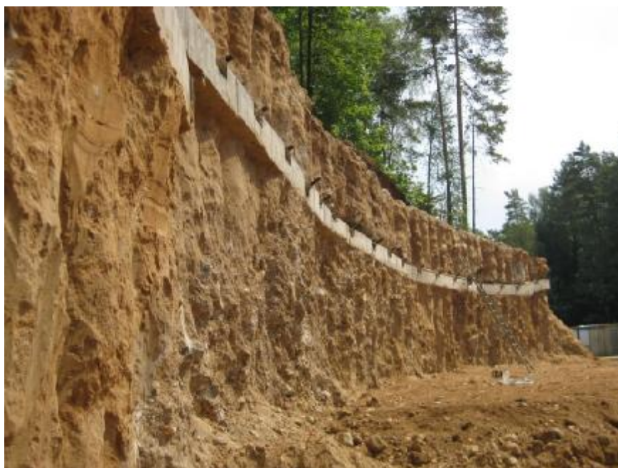
Рис.5. Укрепление подпорной стены анкерами «Атлант»
