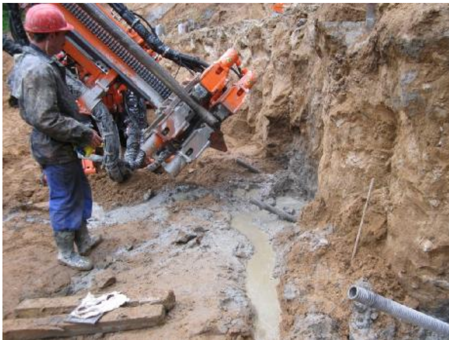
Рис.4. Установка анкеров «Атлант»
