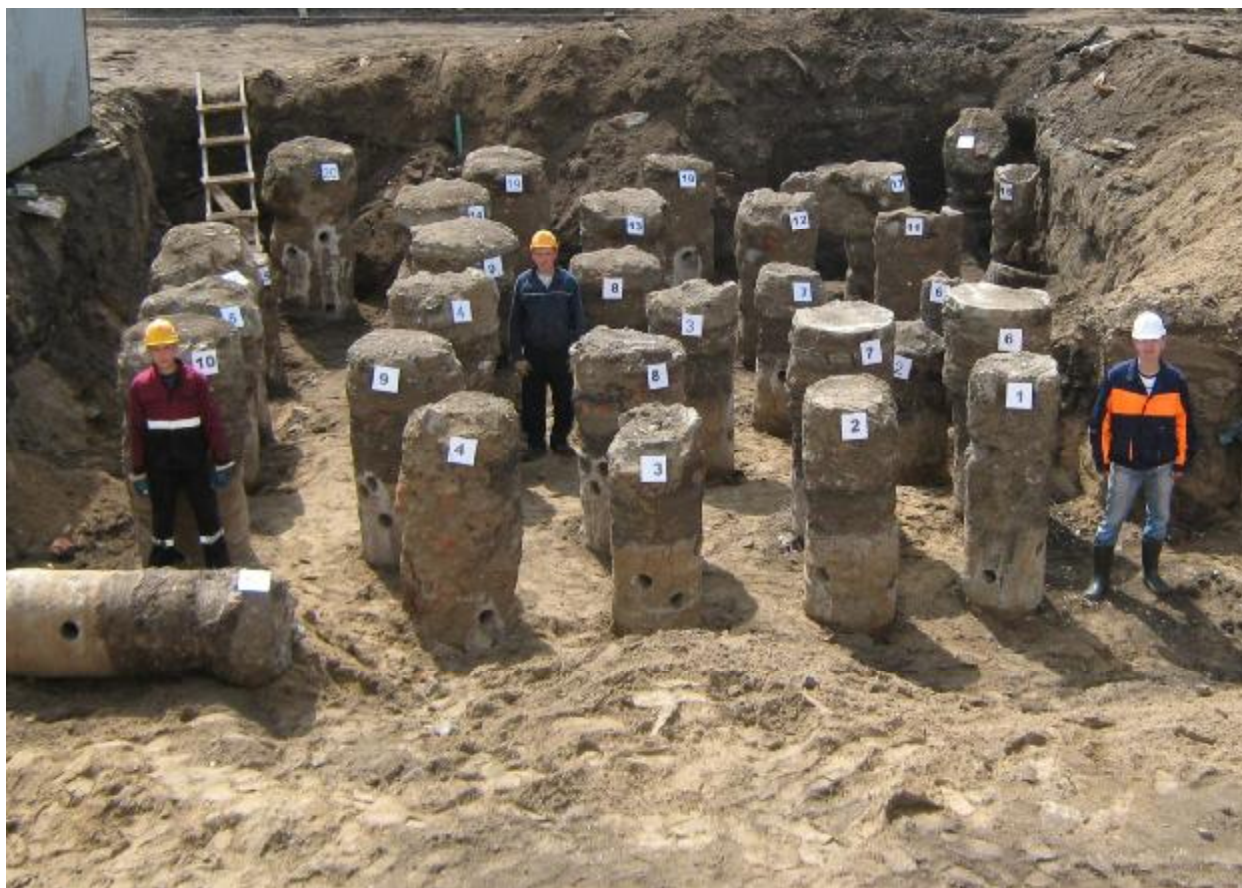
Рис. 6. Опытные грунтоцементные колонны.
