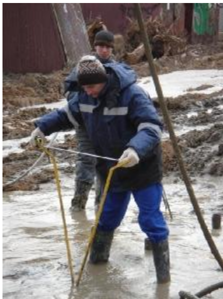
Рис.2 Измерение диаметра колонны с помощью прибора СПР-120.
