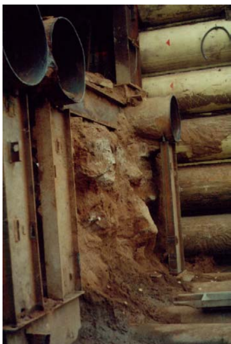
Фото 2. Песчаный грунт в теле тоннеля, закрепленный синтетической смолой.
