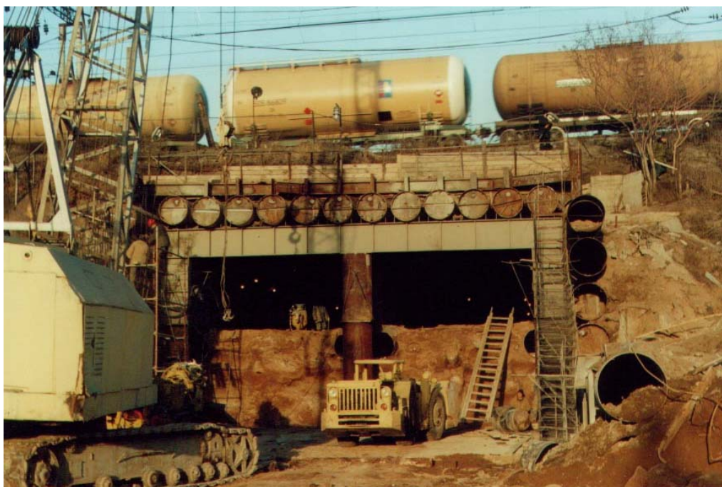
Фото 1. Внешний вид тоннеля в процессе проходки верхнего уступа.
