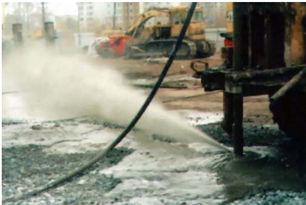
Фото 3. Производство грунтоцементной сваи.
