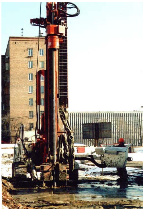
Фото 1. Устройство свай буровой установкой RAPTOR
