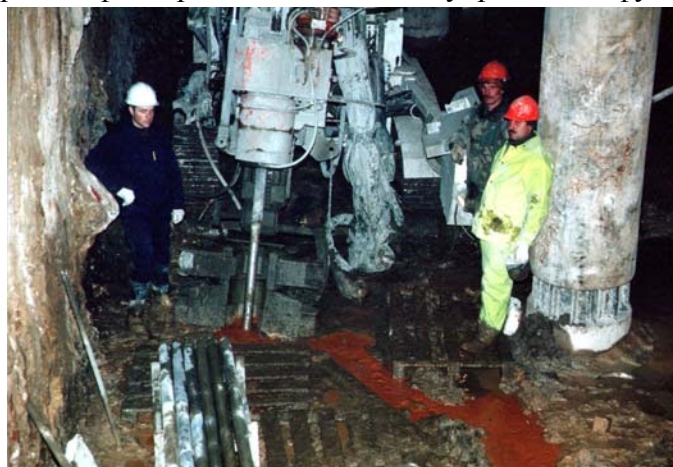
Фото 4. Устройство противофильтрационной завесы с 4-го подземного этажа Арбат-Центра.
