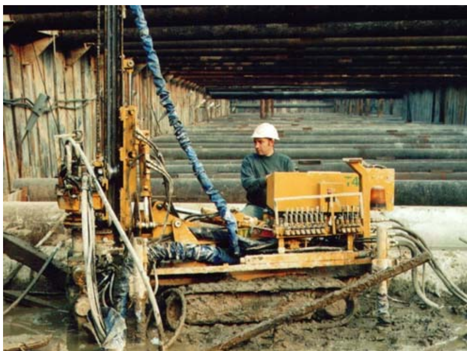
Фото 2. Устройство горизонтальной противофильтрационной завесы в днище котлована.
