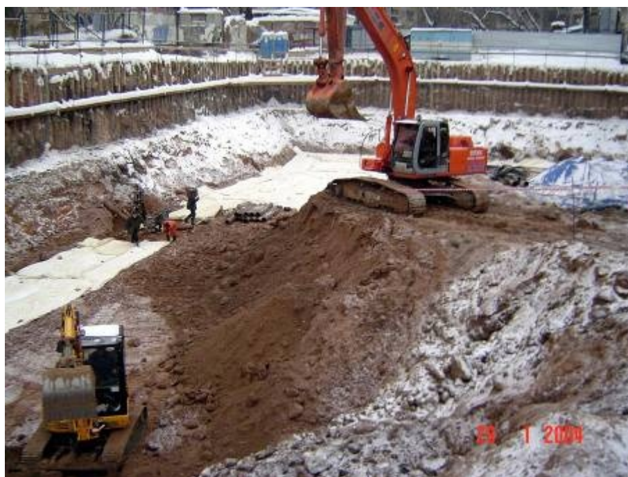
Фото 5. Внешний вид котлована после устройства ПФЗ.
