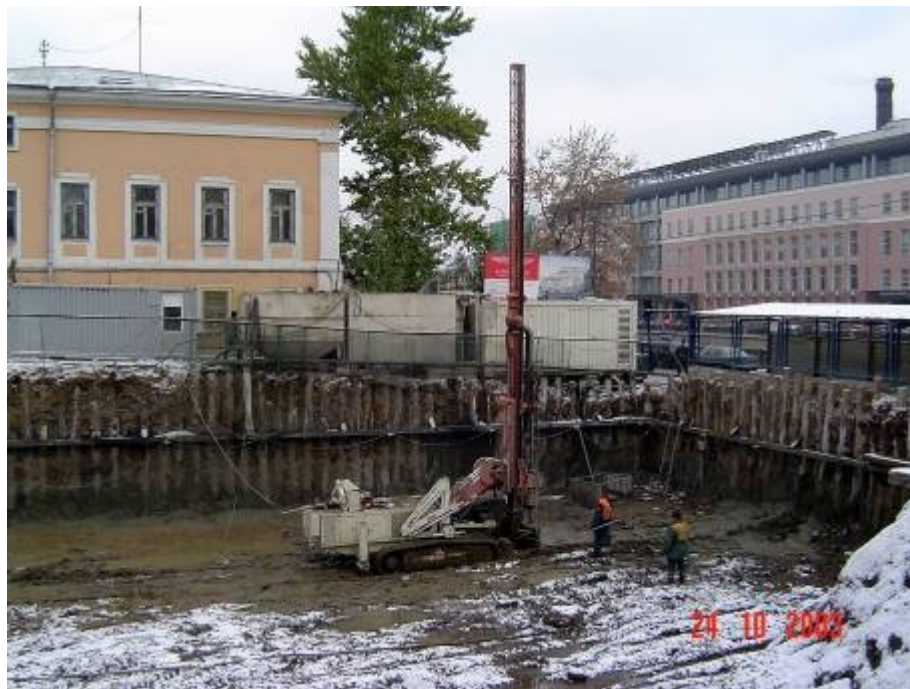
Фото 3. Производство работ по устройству ПФЗ.
