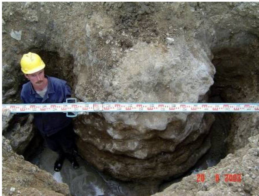
Фото 2. Грунтоцементная колонна диаметром 1800 мм.
