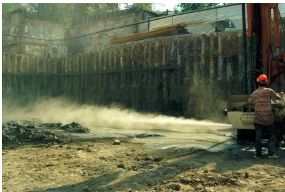
Фото 1. Высоконапорная струя цементного раствора.
