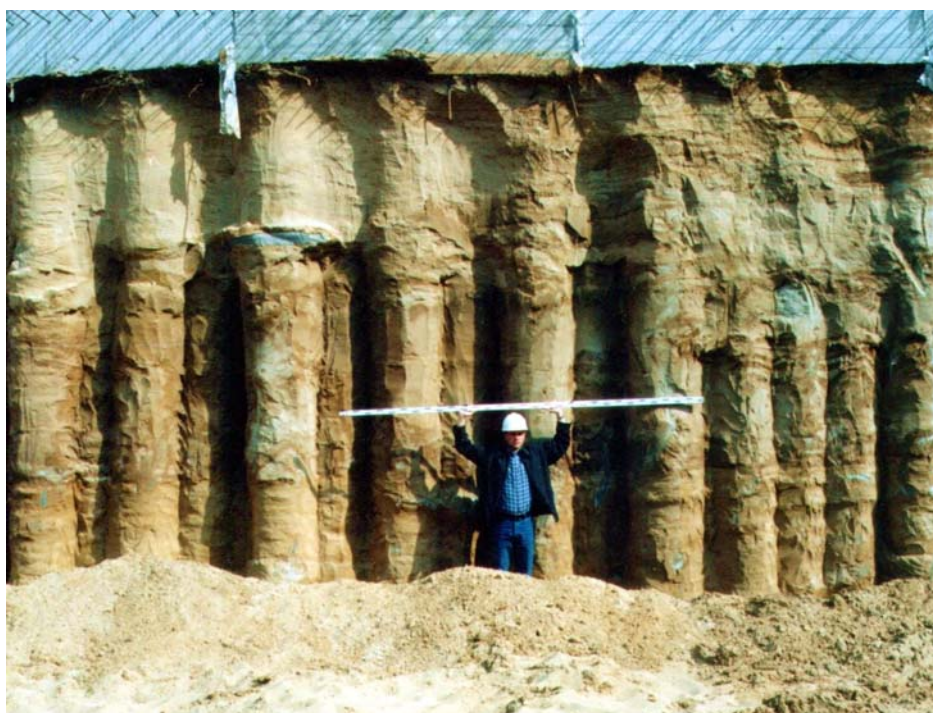
Фото 1. Борт котлована из свай.
