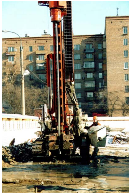
Фото 2. Устройство грунтоцементных свай буровой установкой Raptor.
