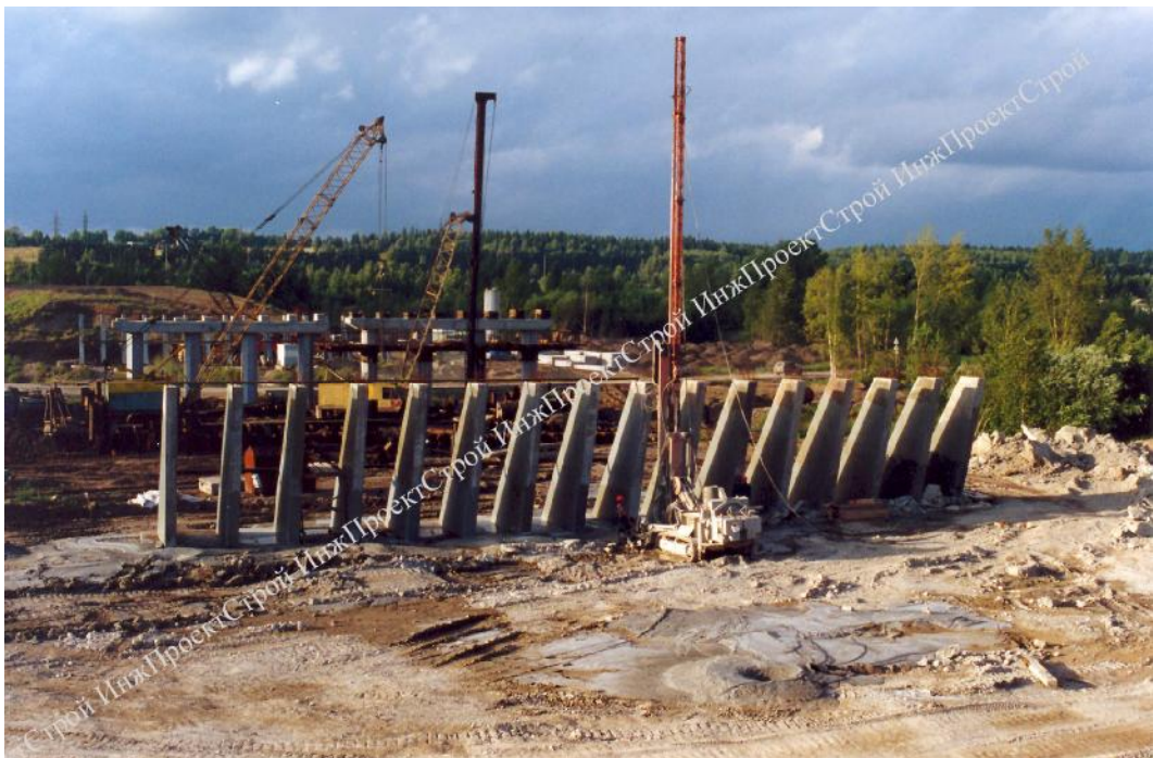
Фото 1. Производство работ по струйной цементации грунтов
