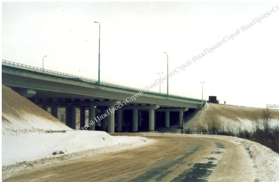
Фото 3. Строительство путепровода завершено
