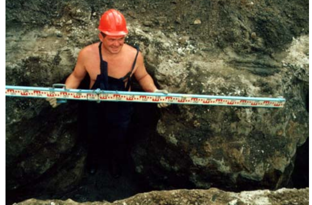
Фото 5. Вид грунтоцементных свай при проходке опытного шурфа.
