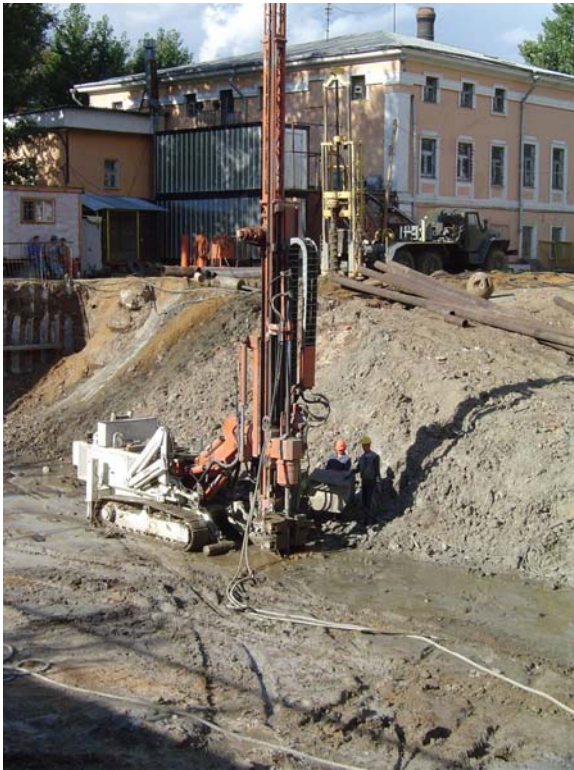
Фото 4. Устройство противофильтрационной завесы в днище котлована.
