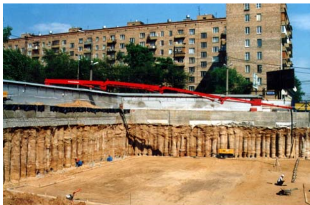
Фото 1. Внешний вид котлована по ул. Мытной.
