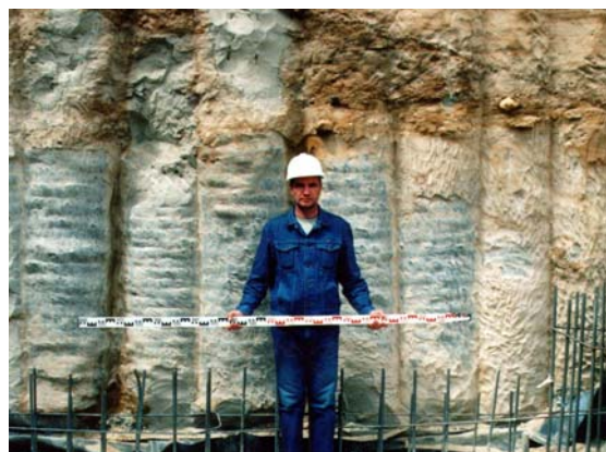
Фото 2. Руководитель объекта Казаков А.В. на фоне выполненных свай.
