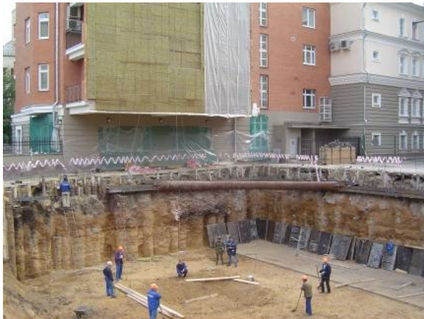
Рис. 5 Пример устройства ограждающей конструкции из грунтоцементных свай
