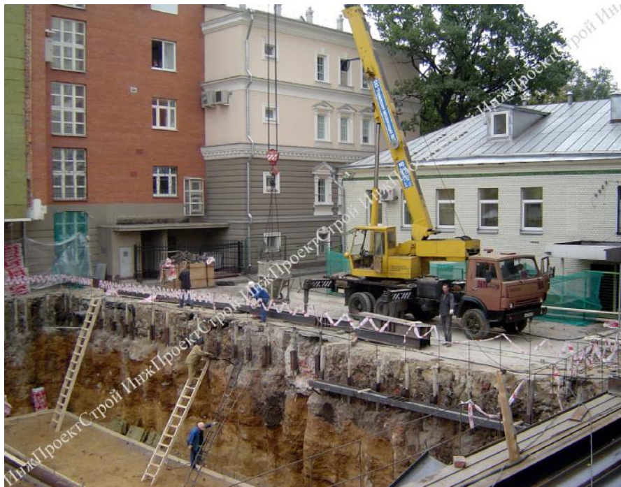
Фото 4. Ограждение котлована из грунтоцементных свай без установки распорной системы.
