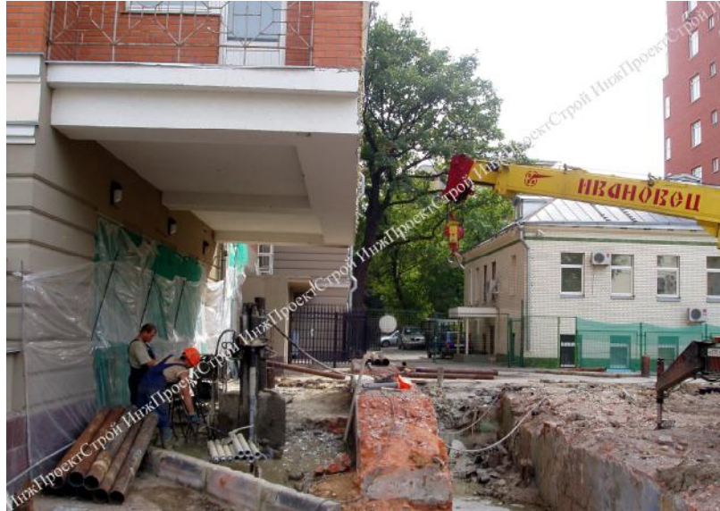
Фото 3. Производство работ в стесненных условиях под консолью соседнего здания.
