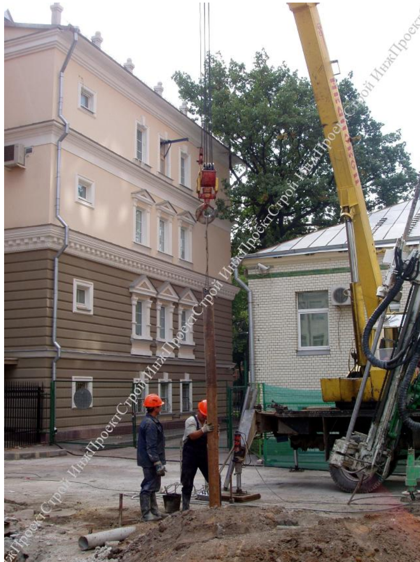
Фото 2. Армирование грунтоцементной сваи металлической трубой.
