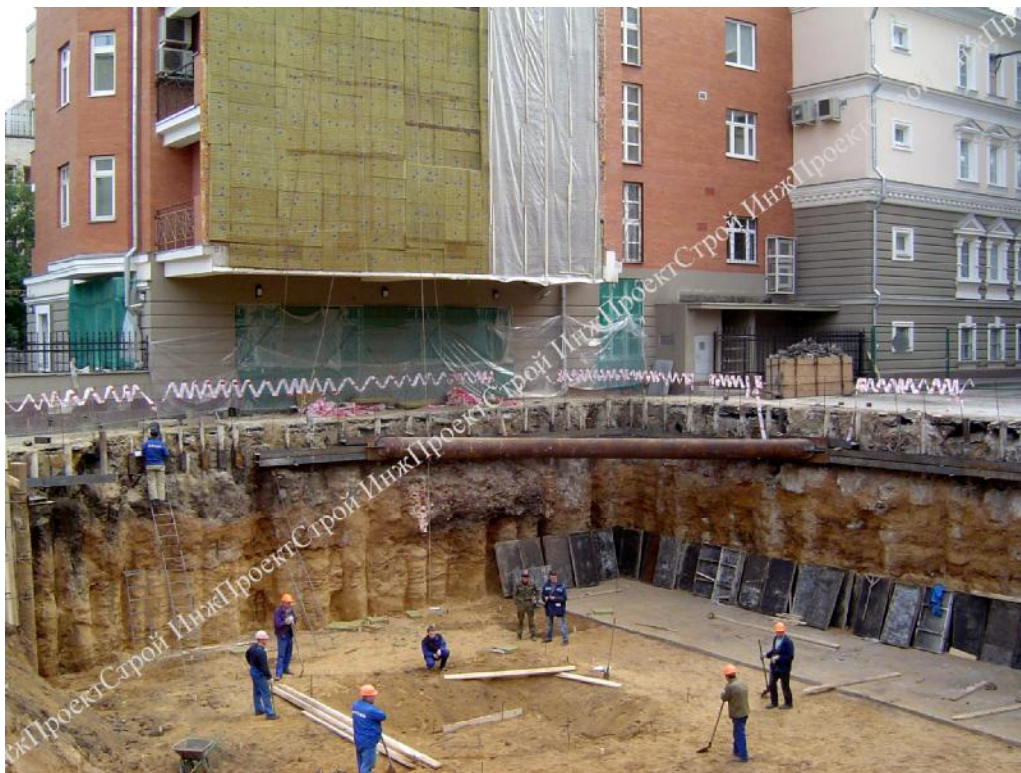
Фото 5. Общий вид ограждения котлована из грунтоцементных свай.
