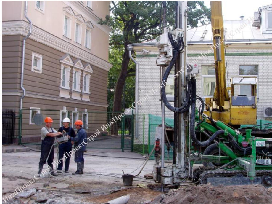
Фото 1. Устройство грунтоцементных свай для ограждения котлована.
