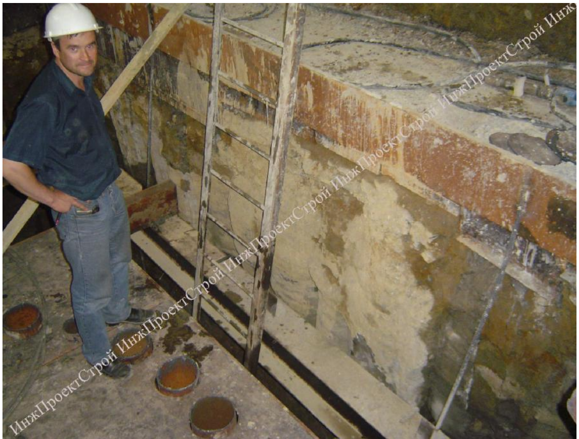
Фото 2. Вид грунтоцементных свай на первом этапе – строительство подземной камеры.
