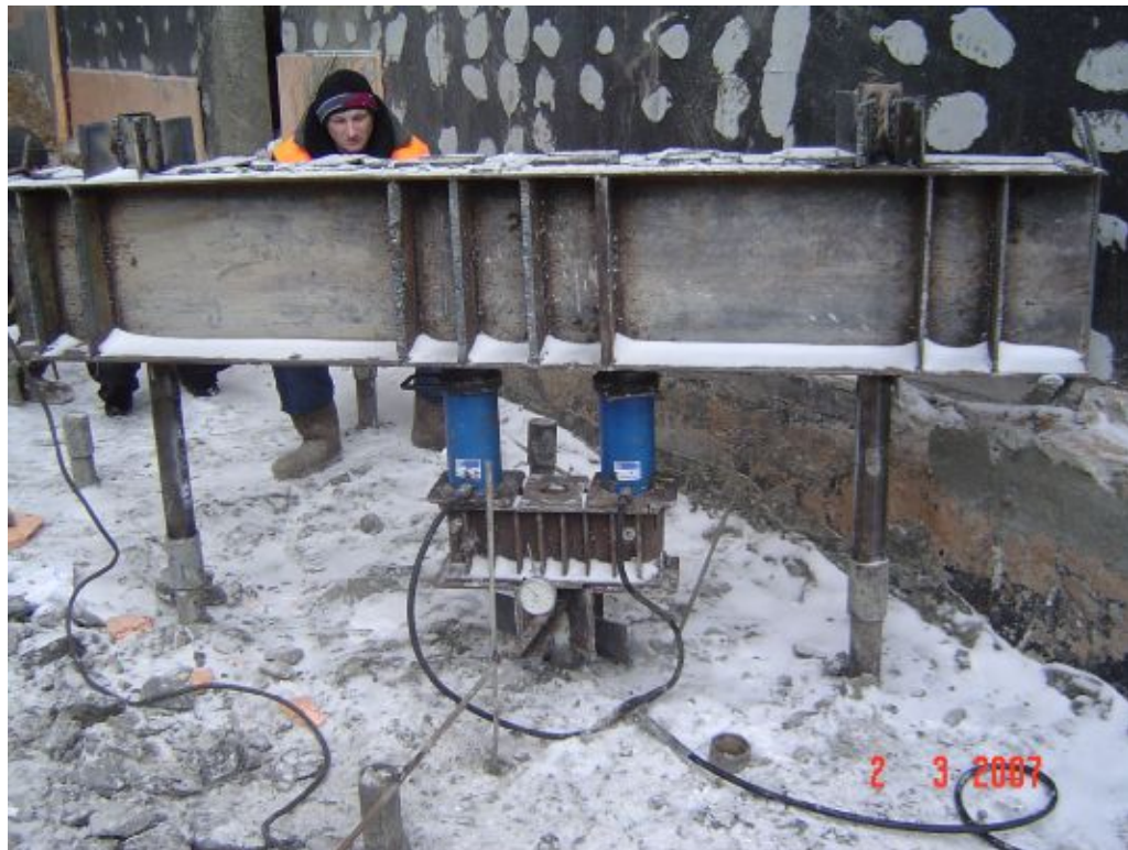
Фото 1. Установка для испытания сваи вдавливающей нагрузкой.
