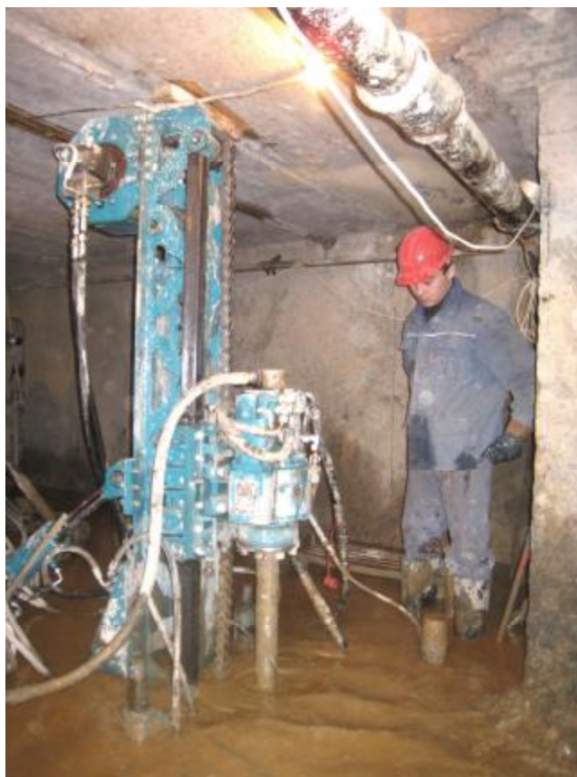
Рис.9. Выполнение работ на буровом станке «Figaro» в г.Екатеринбург
