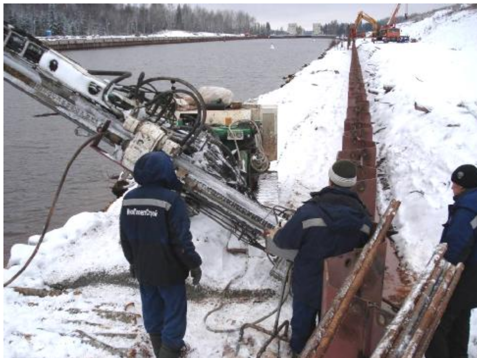
Рис.3. Установка рабочих анкеров
