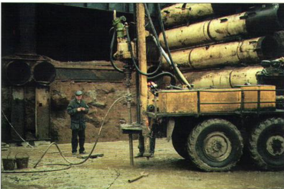
Рис. 3. Сооружение грунтоцементных свай
